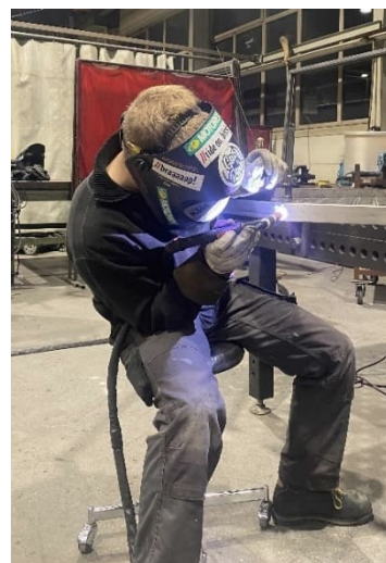
Bild 34: Verschweissen der Beckenrahmen und Verstrebungen
