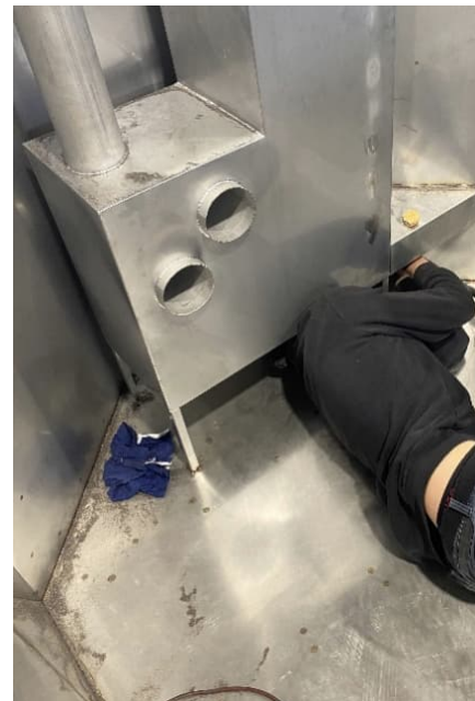
Bild 50: Einschweißen des Ofens
