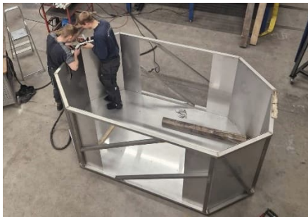
Bild 41: Einsetzen und Heften der Seitenbleche
