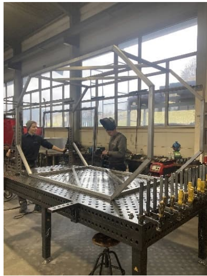
Bild 35: Fertigstellen des Grundrahmens
