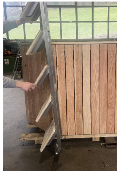
Bild 65: Einsetzen der Treppe unten und abklappen auf den Beckenrand
