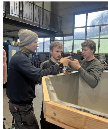
Bild 54: Unterkonstruktion der Holzverkleidung montieren, damit die Verkleidung danach einfach verschraubt werden kann
