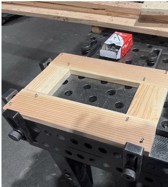
Bild 59: Unterkonstruktion der Sitzbänke auf dem «Holz-Schweisstisch» zusammenbauen
