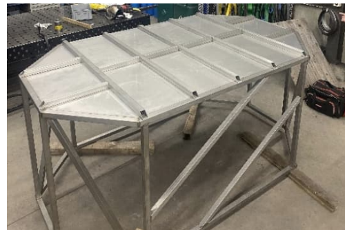
Bild 38: Einsetzen Bodenblech und Verschweissen Bodenverstrebungen
